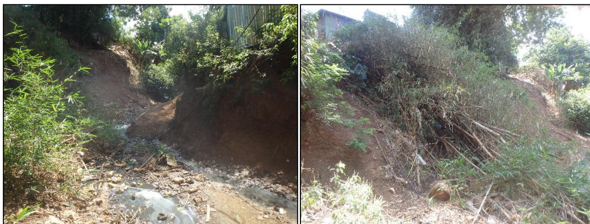
Figure 33 : Embâcles formés par des bambous après effondrement de la berge
