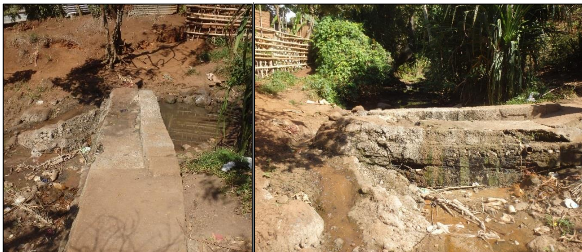
Figure 42 : Seuil artificiel (hauteur de chute d'environ 1,20m) permettant de stabiliser le profil en long de la rivière
