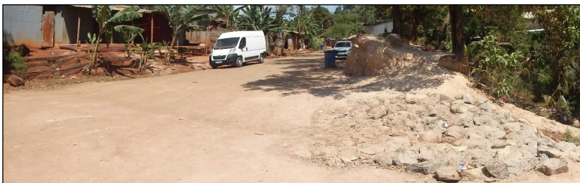
Figure 48 : Ouvrage de gestion des eaux de ruissèlement existant à l'extrémité aval
