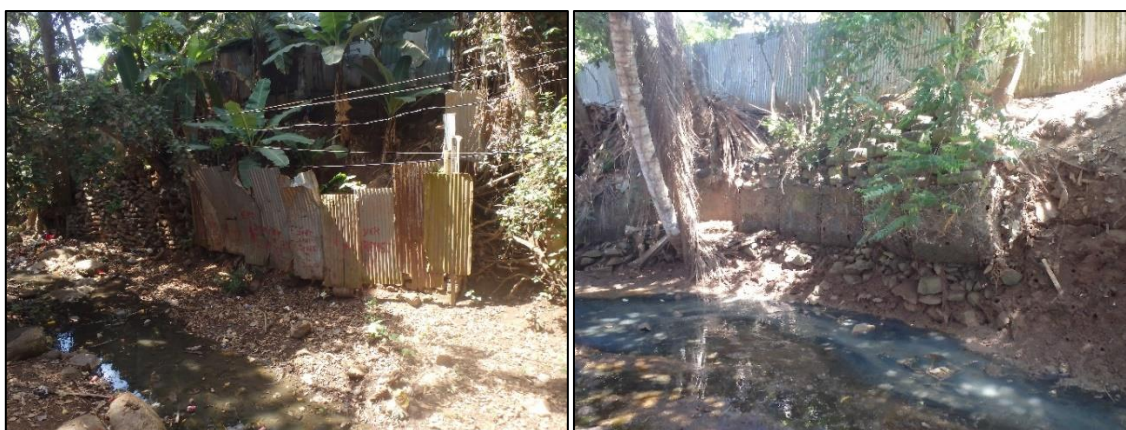
Figure 40 : Tôles ondulées ou « gabions » faisant office de protections de berges
