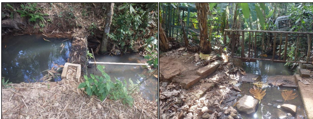
Figure 41 : Ouvrages de type seuils présents en partie amont de la zone d'étude
