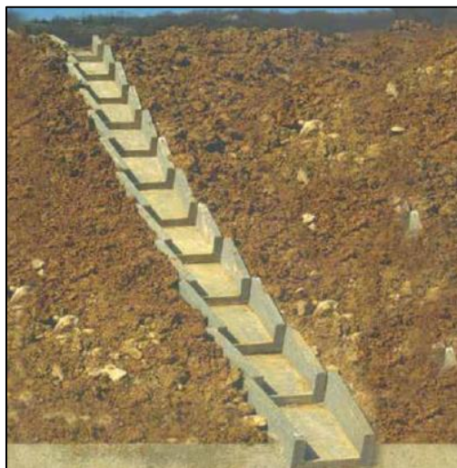
Figure 13 : Illustration des descentes d'eaux tuilées
