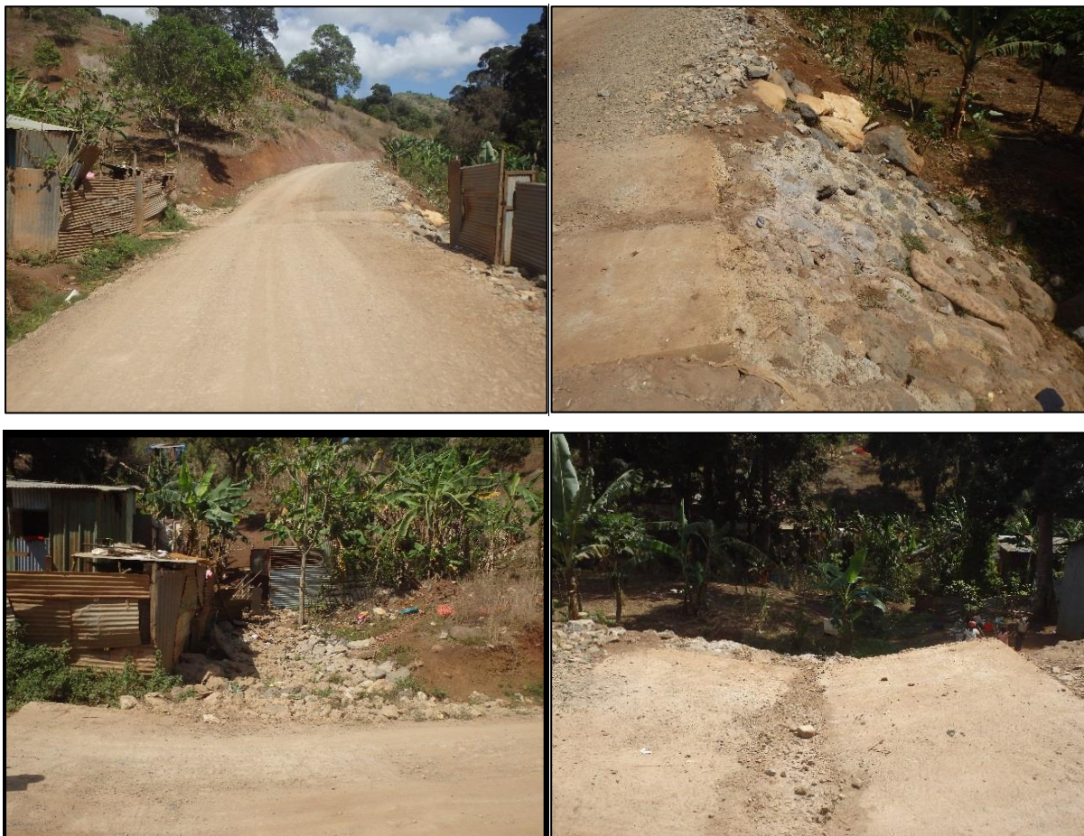
Figure 47 : Cunettes bétonnées en « v » et enrochement liaisonné en partie aval
