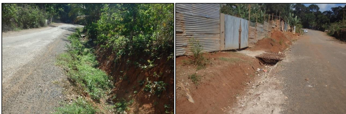
Figure 37 : Fossé en terre mis en œuvre le long de la piste
